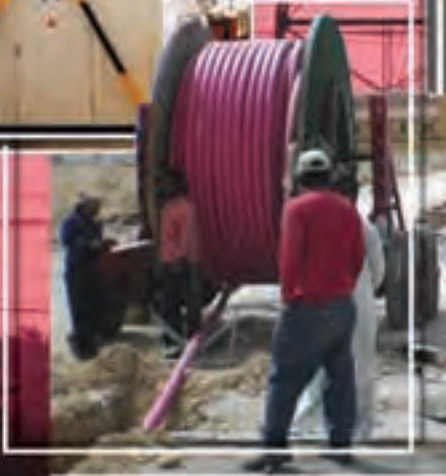
تمديد خطوط كهرباء أرضية
